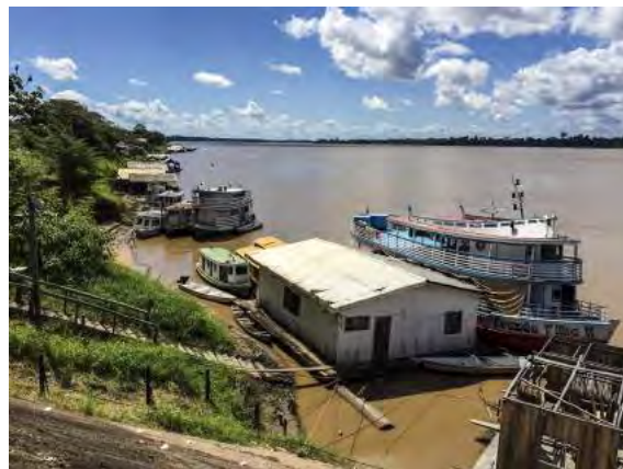
Figura 41. Construções flutuantes às margens do rio Madeira. (IBAM / PQGA, 2016).
