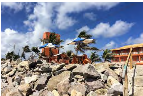
Figura 14. Hotel instalado junto na praia, em área influenciada pela frequente variação de marés. (IBAM/PQGA, 2016).
