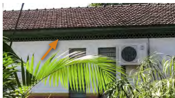
Figura 6. Uso de forro ventilado no telhado da edificação Alta Floresta/MT. (IBAM/PQGA, 2016).
