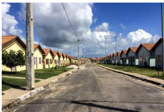
Figura 17. Conjunto do PMCMV, com 1.300 unidades habitacionais padronizadas. (IBAM/PQGA, 2016).
