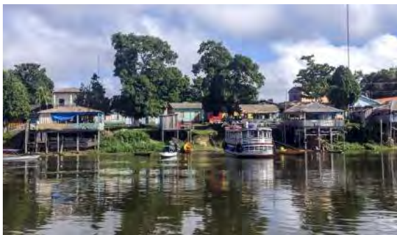
Figura 25. Construções típicas, às margens do rio Tapajós no Pará. (IBAM/PQGA, 2016).
