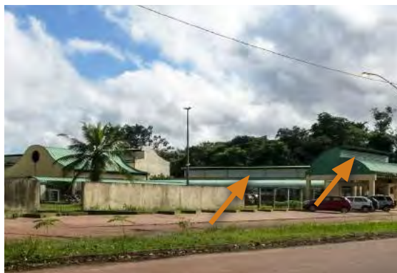
Figura 3. Exemplo de utilização de shed para a ventilação e renovação constante do ar (Itaituba/PA). (IBAM/PQGA, 2016).
