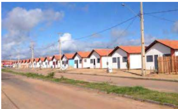
Figura 21. Uniformidade do padrão de construção do conjunto do PMCMV. (IBAM/PQGA, 2016).
