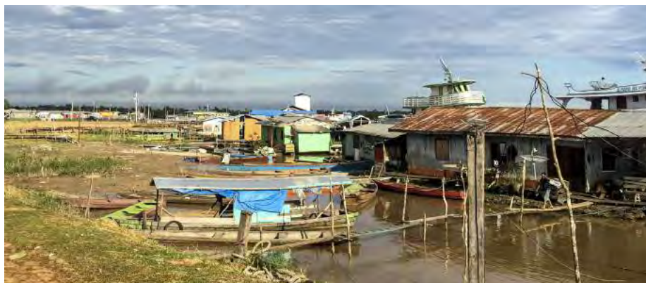
Figuras 37. Casas às margens do rio Purus. Infraestrutura deficiente e utilização de passarelas precárias em madeira para acesso às casas. (IBAM/PQGA, 2016).
