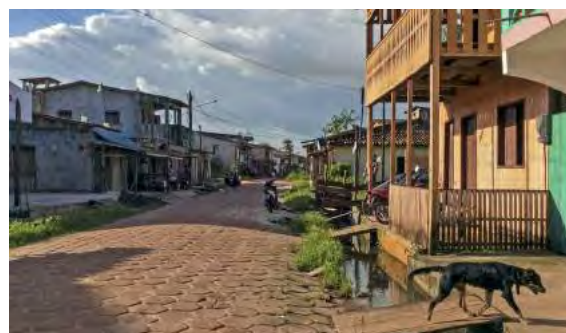
Figura 2. Inadequação da moradia. Deficiência de saneamento básico em bairros populares. (IBAM/PQGA, 2016).
