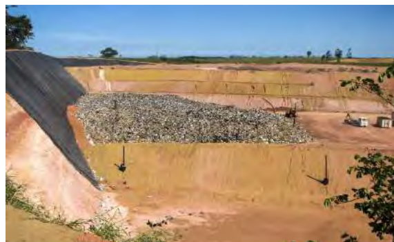
Figura 11. Disposição final em aterro sanitário. (IBAM, 2011).
