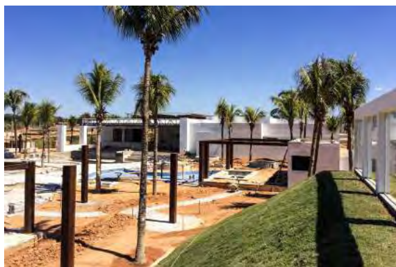
Figura 13. Condomínio fechado de alto padrão em construção na periferia. (IBAM/PQGA, 2016).
