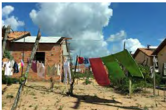
Figura 19. Ampliações de casas sem planejamento, nos fundos dos terrenos do PMCMV. (IBAM/PQGA, 2016).
