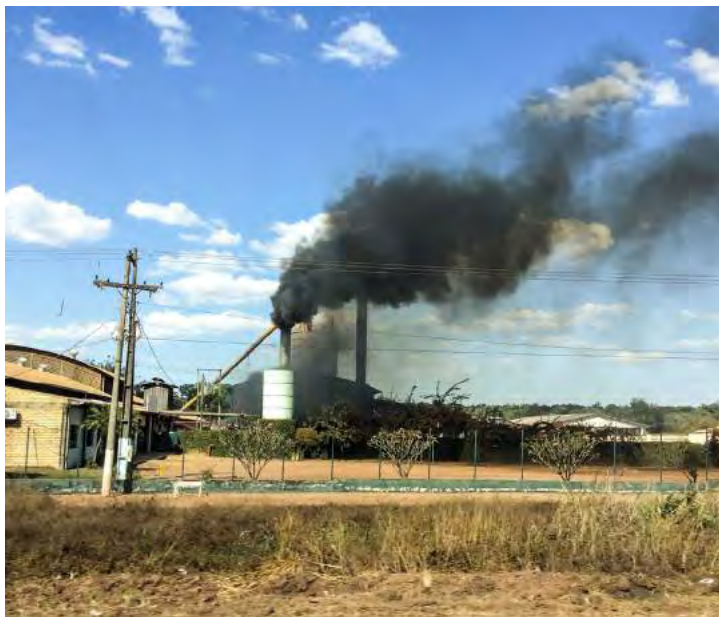
Figura 15. Usina de asfalto. (IBAM/POGA, 2016).
