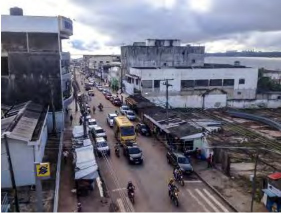
Figura 16. Quadro de desordem urbana (ocupação de passeios e vias por atividades econômicas, falta de demarcação correta de vagas para estacionamento de veículos, falta de acessibilidade e lotes vagos sem vedação apropriada). Itaituba/PA. (IBAM/PQGA, 2016).
