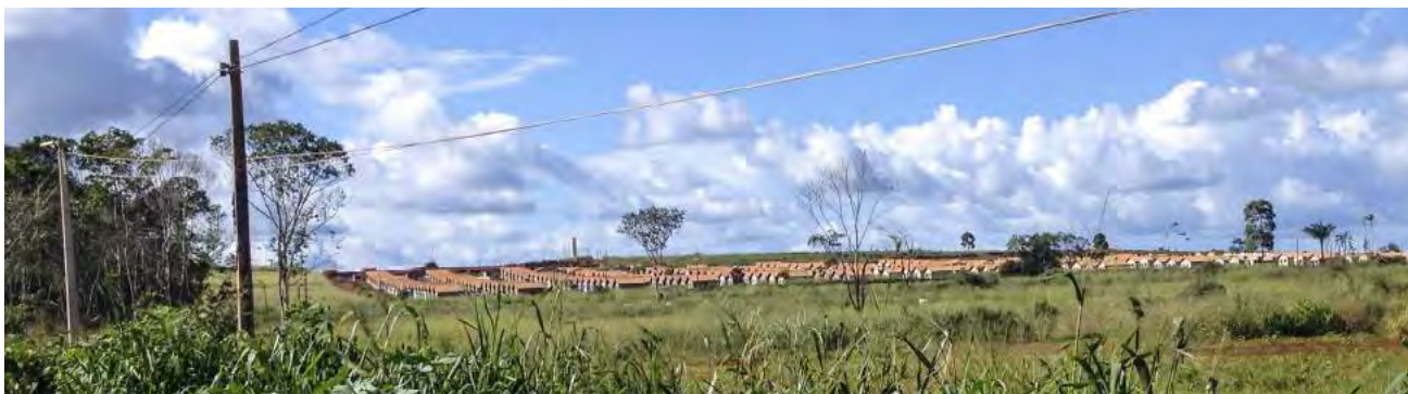
Figura 9. Conjunto habitacional fora da área urbanizada. (IBAM/PQGA, 2016).
