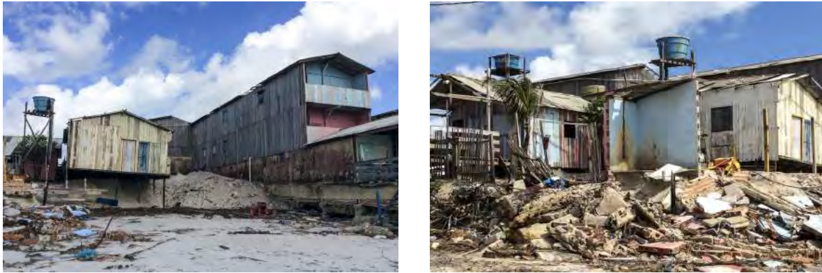
Figuras 8 e 9. Destruição de casas em Ajuruteua, no litoral do Município de Bragança (PA), provocada pelo efeito do avanço das marés. (IBAM/POGA, 2016).
