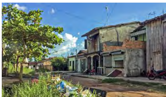
Figura 1. Inadequação da moradia. Carência de serviços básicos em bairros populares. (IBAM/PQGA, 2016).
