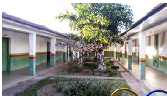
Figura 5. Edificação com pátio interno e varandas, Alta Floresta/MT. (IBAM/PQGA, 2016).
