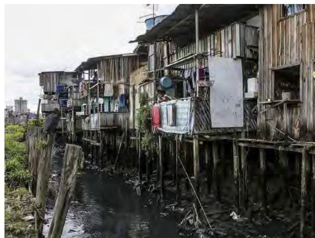
Figura 10. Palafitas construídas sobre a margem de curso d'água, em péssimas condições sanitárias, no Pará. (ESTADÃO, 2015).
