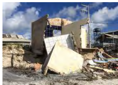
Figura 44. Casas, em alvenaria, não resistem à variação das marés. (IBAM/PQGA, 2016).
