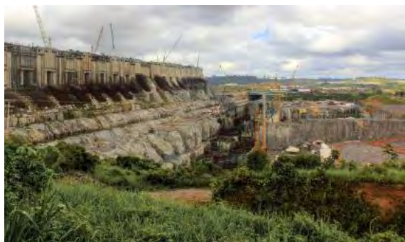
Figura 9. Sítio de construção da hidrelétrica Belo Monte / PA. (LAGUÉNS, 2016).
