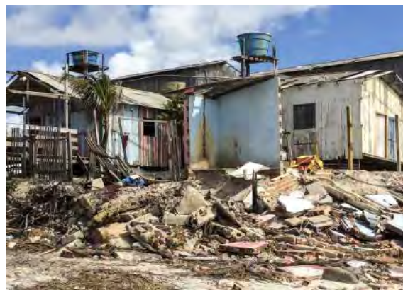
Figura 11 e 12. Residências construídas de forma irregular sobre dunas, em faixa de areia da praia, destruídas pela erosão. (IBAM/PQGA,2016).
