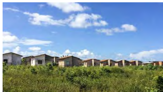
Figura 24. Conjunto habitacional do FNHIS, não concluído e invadido. Sem infraestrutura. (IBAM/PQGA, 2016).
