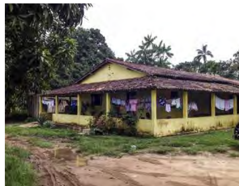
Figura 4. Casa avarandada e telhado coberto com telhas de barro colonial (Brasil Novo/PA). (IBAM/PQGA, 2016).
