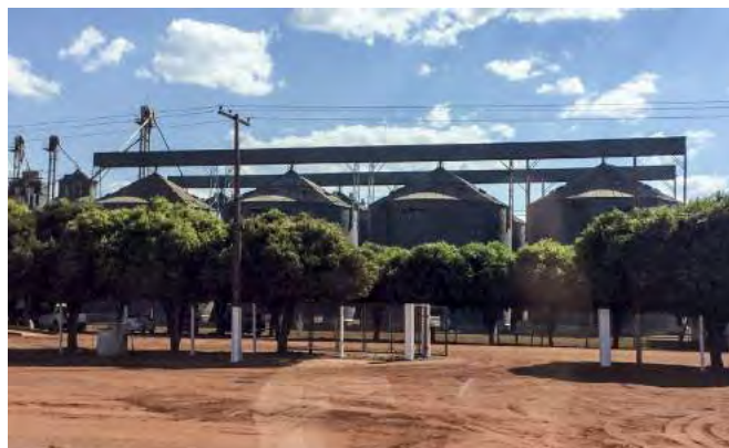
Figura 12. Grandes produtores de grãos. Silos de armazenagem. (IBAM/PQGA, 2016).
