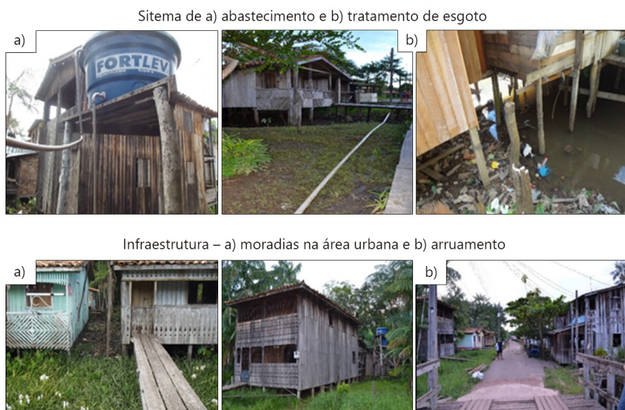
Figura 2 Bairro em área de várzea na cidade de Ponta de Pedras (PA). Fonte: Carmo (2020).
