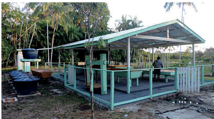
Estrutura da Casa de Farinha. Foto: José Carlos Campana Júnior.
