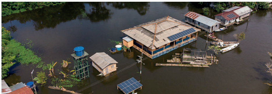
Comunidade de instalação do sistema solar na época de cheia. Foto: João Paulo Borges Pedro.
