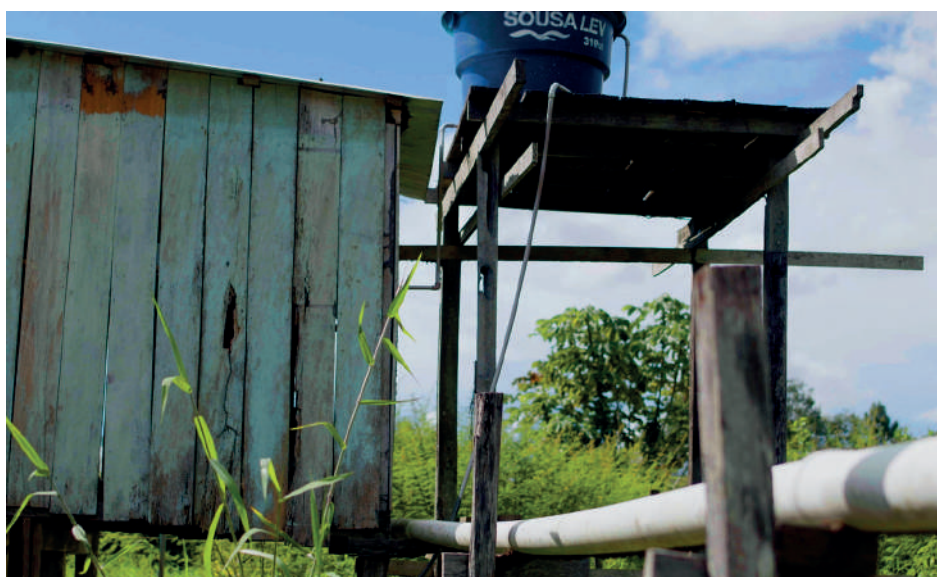
Foto externa de banheiro com sistema da Fossa Alta Comunitária. Foto: Lúcio Silva.
