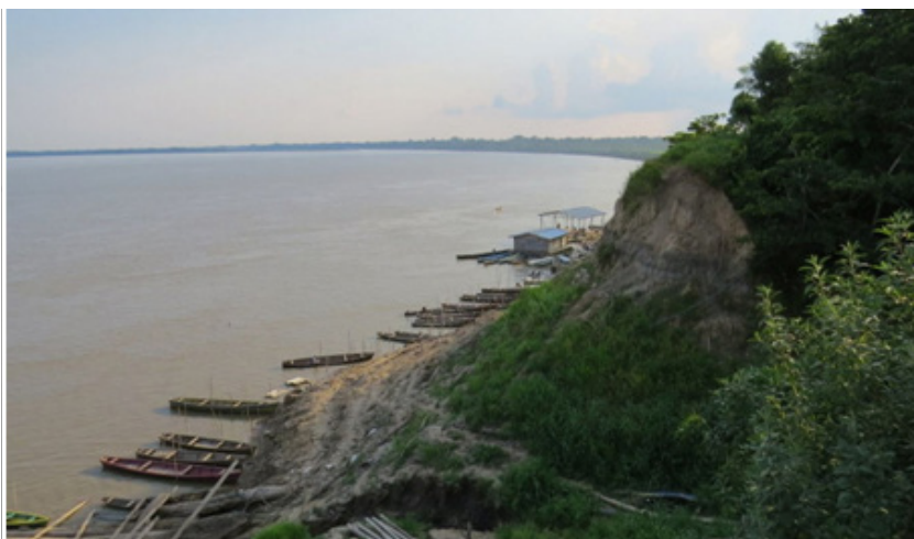
Figura 4: Taludes em Belém do Solimões, agosto de 2015.
