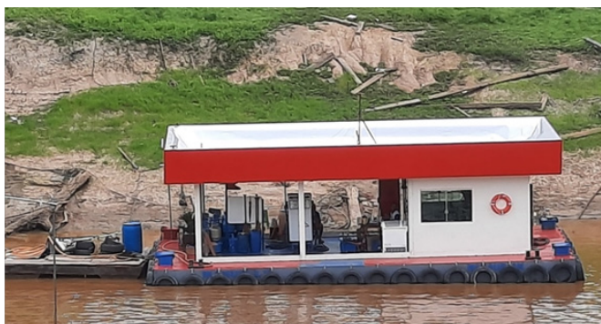
Figura 8 - Posto flutuante na Vila Araçá
