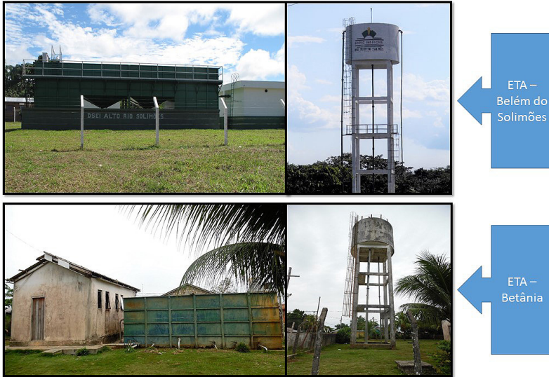
Figura 3: Estação de Tratamento de Água nas Vilas. Fotos: Fernanda Cidade, Acervo Nepecab, 2016.
