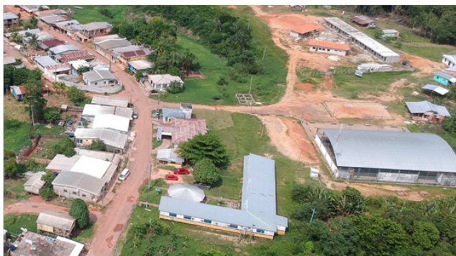
Figura 23 - Construção da escola em alvenaria
