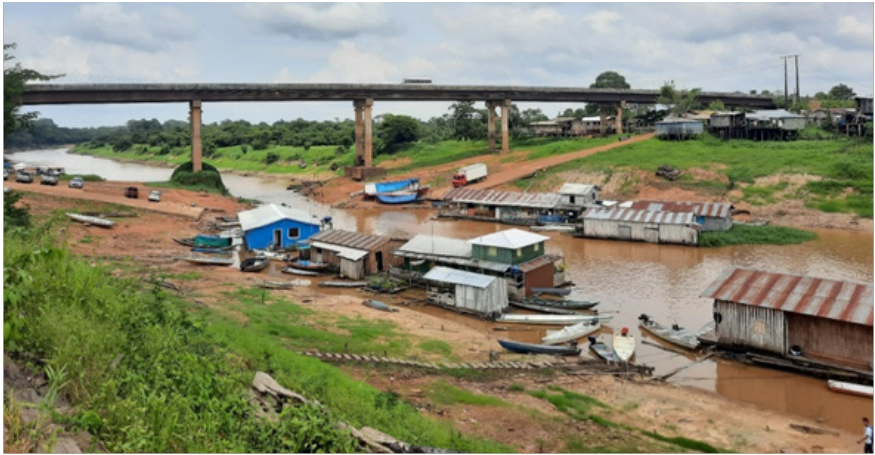
Figura 3 - Ponte sobre o Rio Araçá Fonte: Castro J. V. Outubro de 2020.
