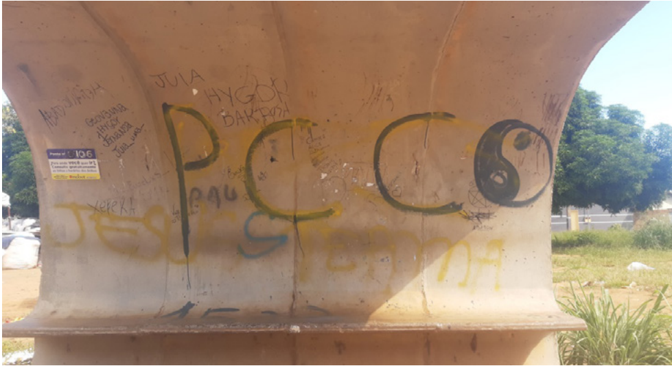
Foto 18 | Pichação do PCC na parada de ônibus no Bairro Vila União Palmas
