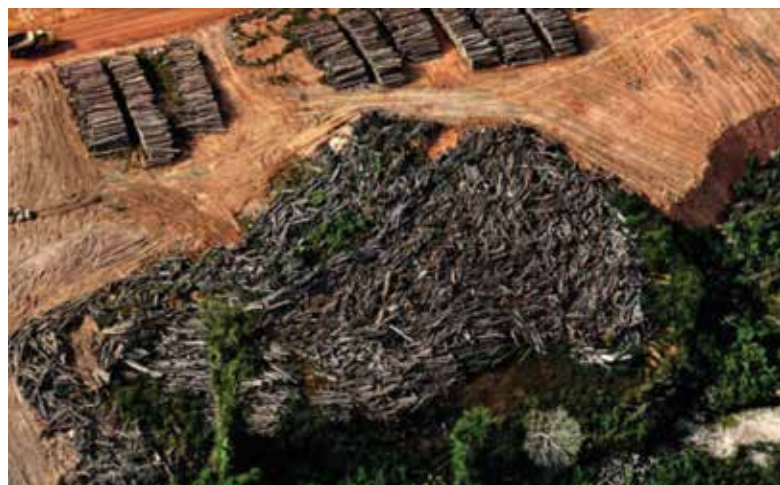
Área de desmatamento para construção da Usina de Belo Monte | Lalo de Almeida – Folhapress
